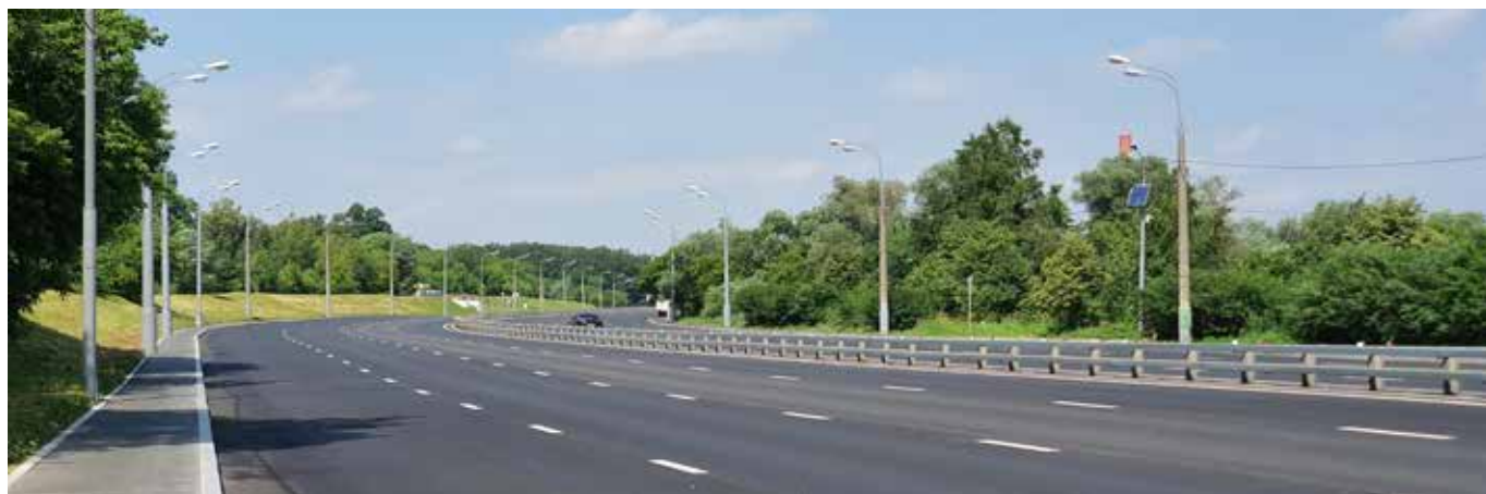
Рисунок 1. Горизонтальная дорожная разметка в процессе эксплуатации
