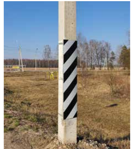
Рисунок 3. Эффективный вариант вертикальной дорожной разметки 2.1.3
