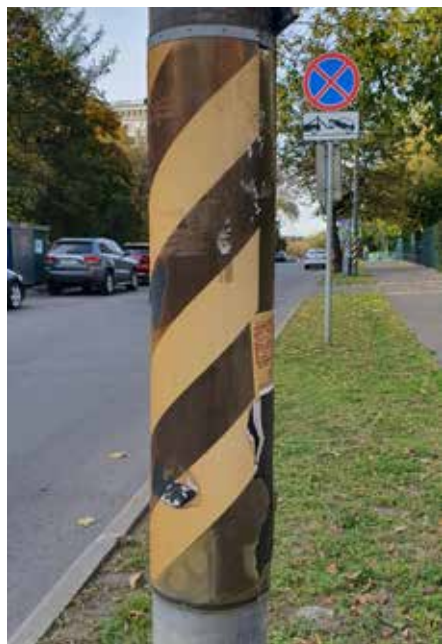
Рисунок 4. Вертикальная дорожная 2.1.3, несоответствующая требованиям ГОСТ Р 51256-2018
