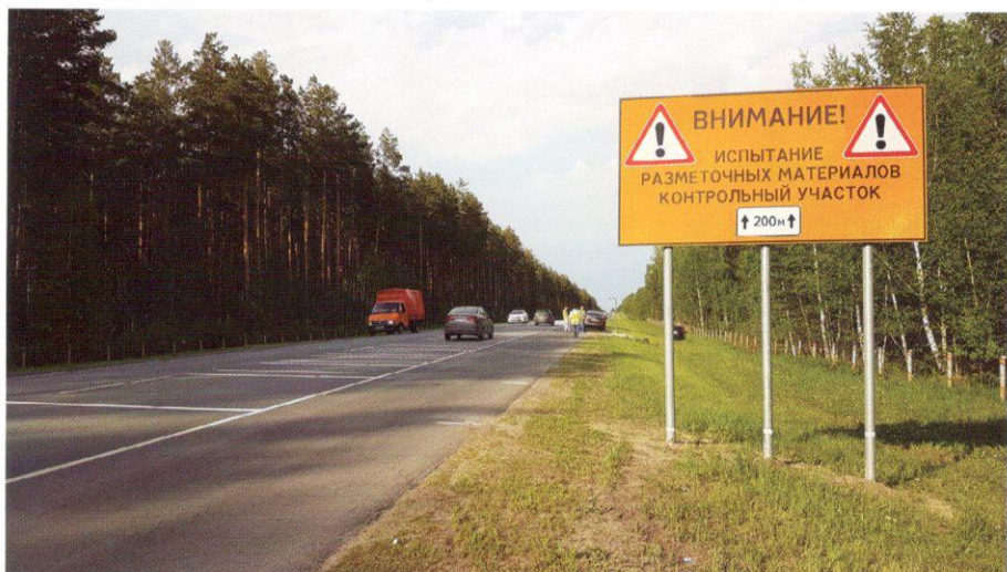
Рис. 2. Внешний вид одного из участков СПИ 2017–2018 после нанесения контрольных линий
