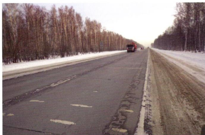
Рис. 4. Внешний вид участка СПИ 2017–2018 на автомобильной дороге Р-255 на участке Северного обхода г. Новосибирска, км 29 (с цементобетонным покрытием)
